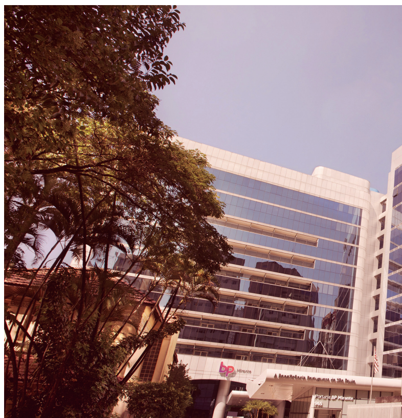
Fachada do BP Mirante.
